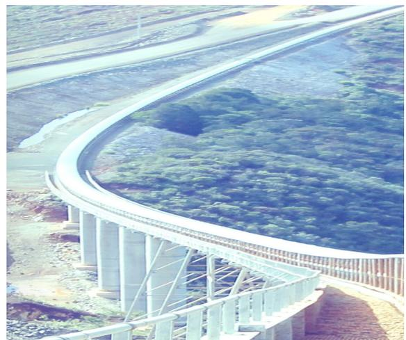
*Les convoyeurs rectilignes ou avec une ou des courbes convexes et/ou concaves ont un profil en long (en élévation) parfaitement visible sur un plan de coordonnées **XY**.*
